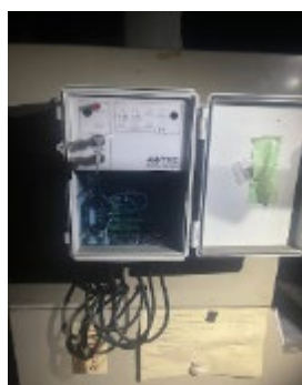
火災センサーのモニター アラーム検知されると検知箇所が点灯する。 ※下の張り紙は火災検知器発報時の対応手順
