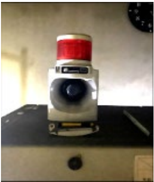
火災センサーランプ アラーム検知されると点灯するとともにアラート音が出る。
