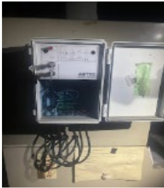
火災センサーのモニター アラーム検知されると検知箇所が点灯する。 ※下の張り紙は火災検知器発報時の対応手順書
