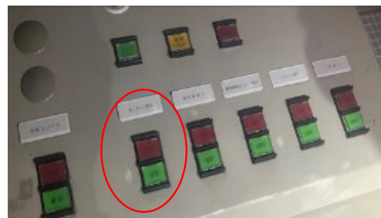
【操作室・散水システム操作盤】 赤:ON 緑:OFF
