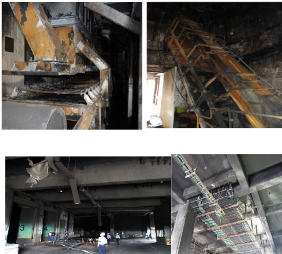
出火元の「粗大ごみ処理施設・破碎物排出コンベヤ」(左上) 中層部(右上) ごみ焼却施設 プラットホームの様子(左下) 天井に敷設された電気配線(右下)
